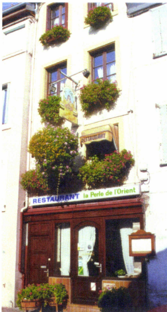
■ Façade commerciale rue de Belfort à Montbéliard
