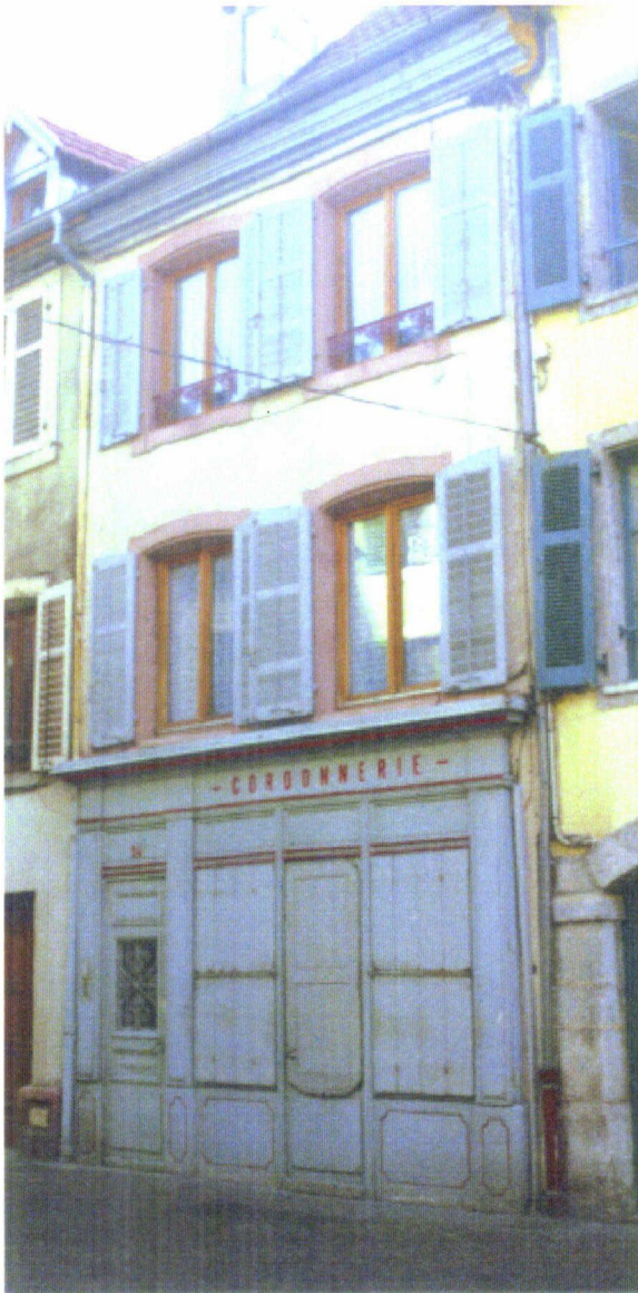
■ Façade commerciale rue de Belfort à Montbéliard
