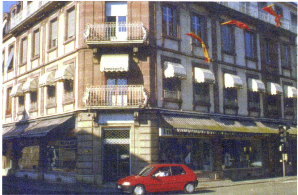
■ Exemple de façade de la fin du 19 ème siècle conçue dès l'origine avec des vitrines
