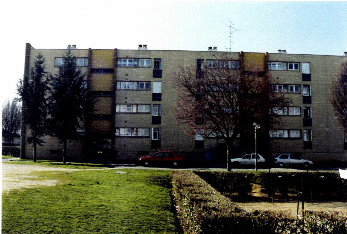
Façade sur entrée
