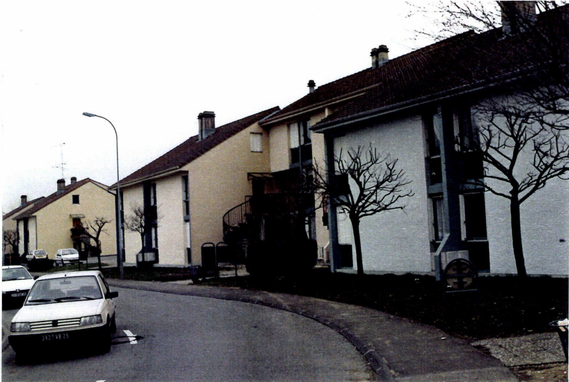
Façades sur rue
