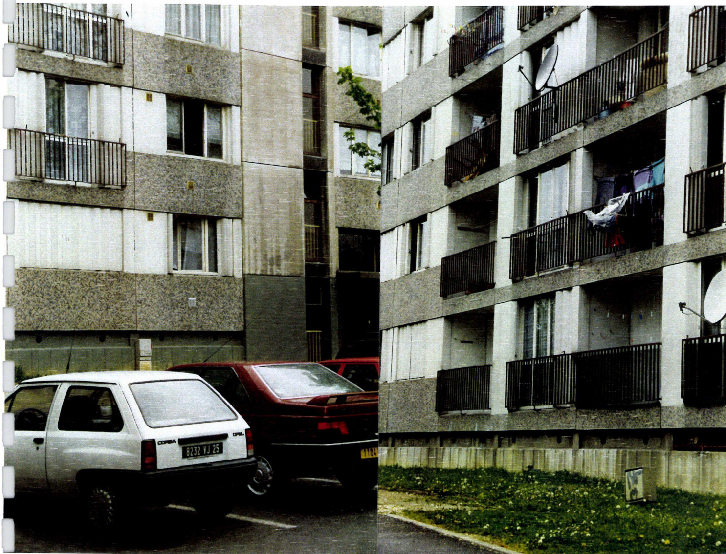
Façade sur entrée
