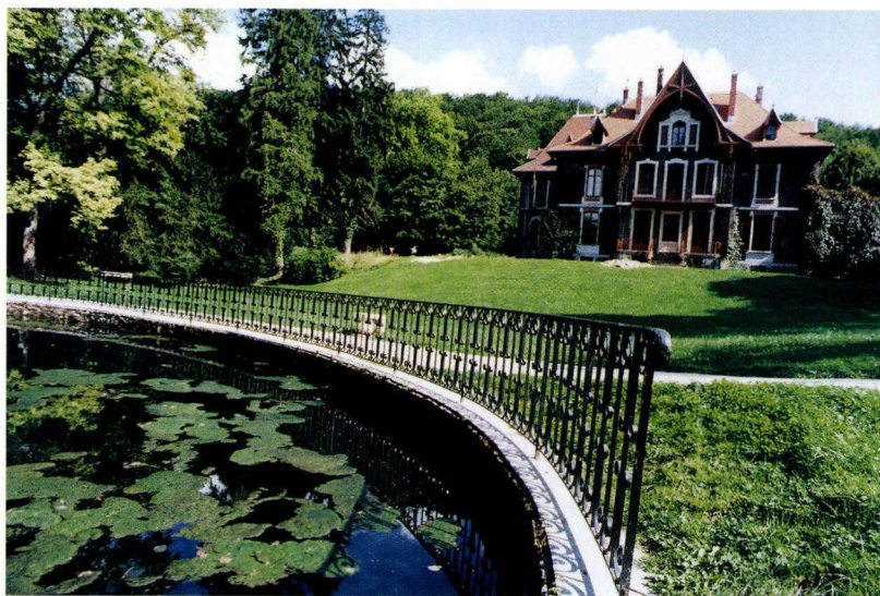
Une ancienne maison de maître abrite les installations du CICV-Centre de recherche Pierre Schaeffer.
