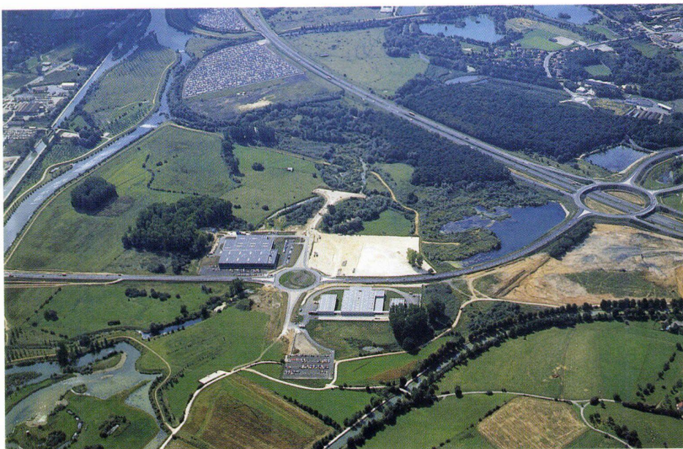
Échangeur de l'autoroute A36, desserte directe du site de Technoland
