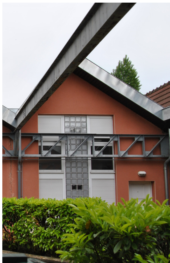
Requalification des friches industrielles à Troyes - Source : ADU
