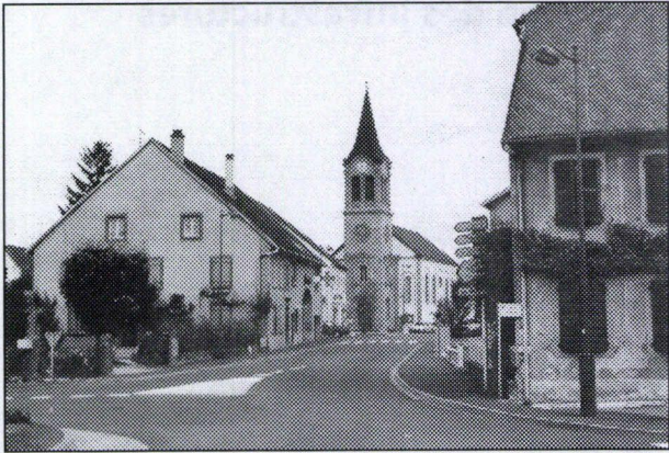
Traitement du centre bourg de Grand-Charmont
