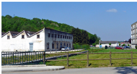
Usine du Rondelot à Fesches-le-Châtel et dérivation de la Feschotte
