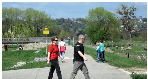
Bart, Eurovéloroute 6 sur ouvrage de lutte contre les inondations
