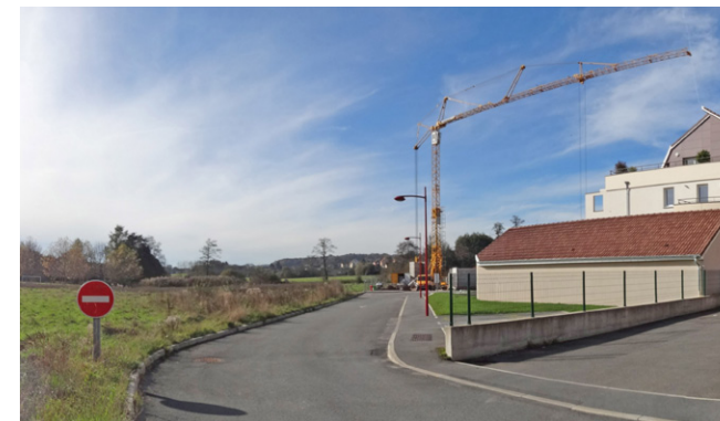
Opération immobilière en limite de la plaine inondable de la Douce à Bavilliers (AUTB, 2012)
