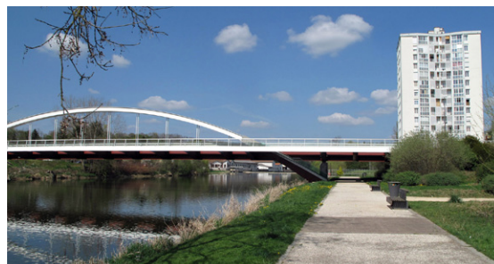
Le Doubs à Audincourt, pont Bollardière (ADU, 2014)
