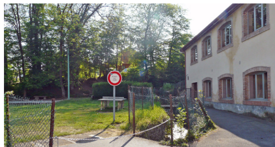
La Feschotte à Badevel, ancienne usine Japy (ADU, 2011)
