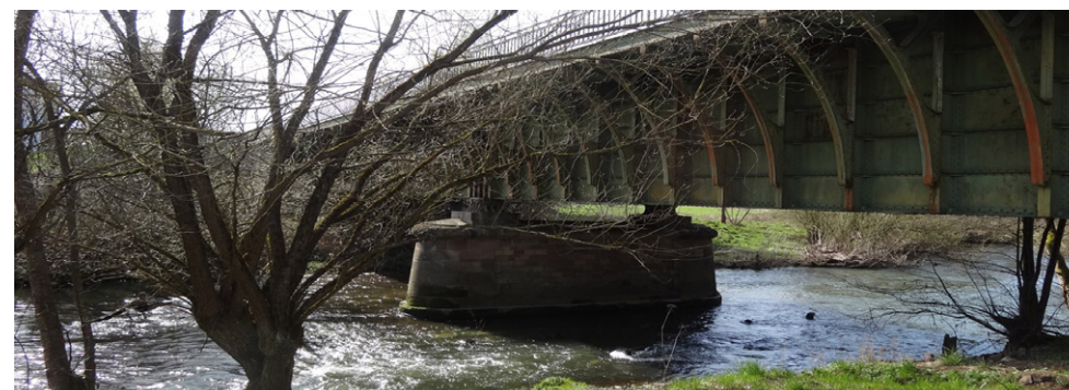
Le pont-canal sur la Savoureuse, à Bermont (AUTB / JJ, 2015)
