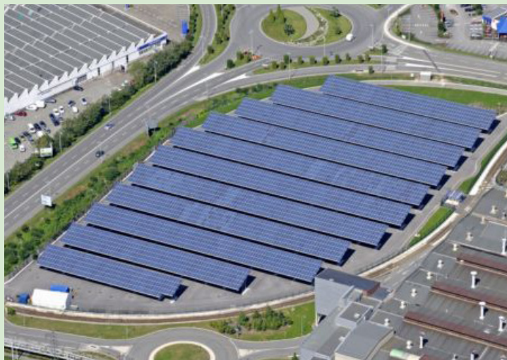
Centrale photovoltaïque de PSA installée en 2010
