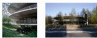
Parking relais des rives de l'Aar à Schillingheim Maître d'œuvre : Michel Desvigne 570 places intégrées dans le paysage urbain
