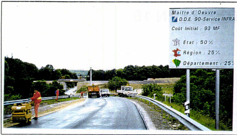
L'échangeur de Sévenans-Dorans en chantier
