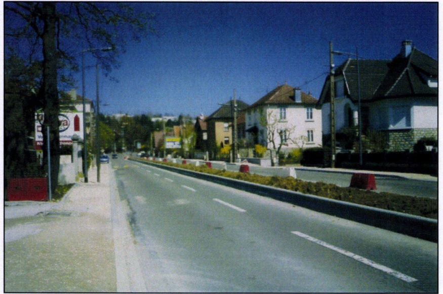
Avenue Chabaud Latour depuis le rond point d'Hélevétie (travaux en cours)
