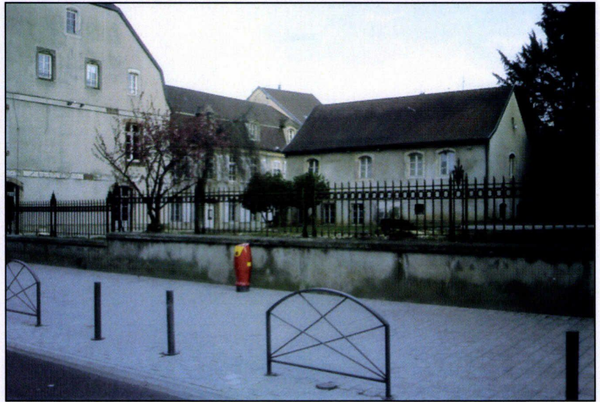
Square Sponeck vu depuis la rue Clémenceau (travaux en cours)
