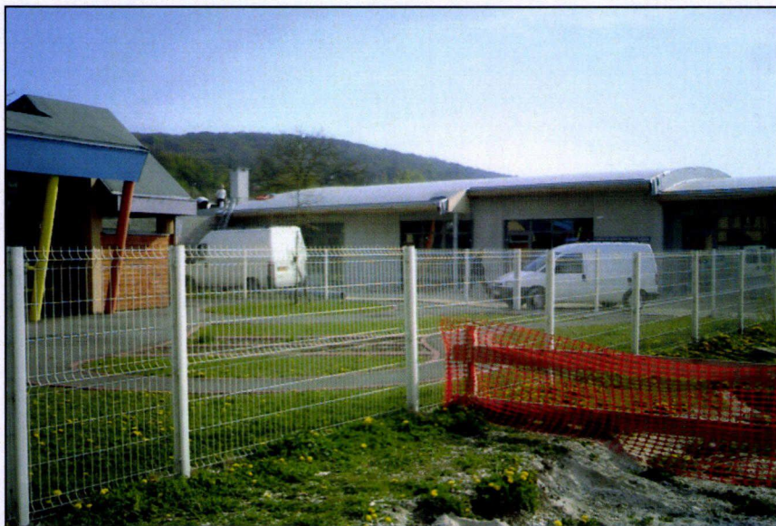
Espace éducatif pluriel à proximité de la halte-garderie (travaux en cours)
