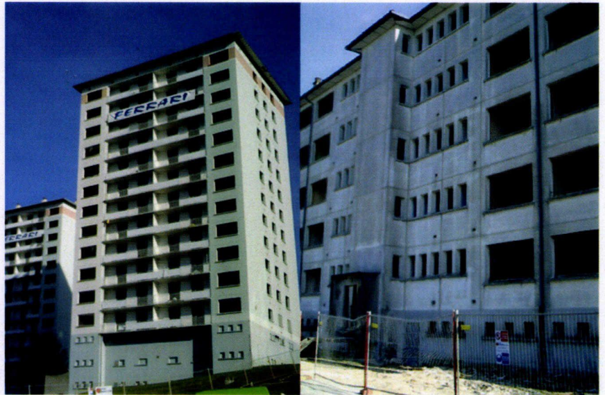
Bâtiments Savoie et Dauphiné (Travaux en cours)
