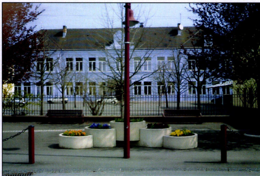
Ecole Marcel Levin à Seloncourt (état actuel)
