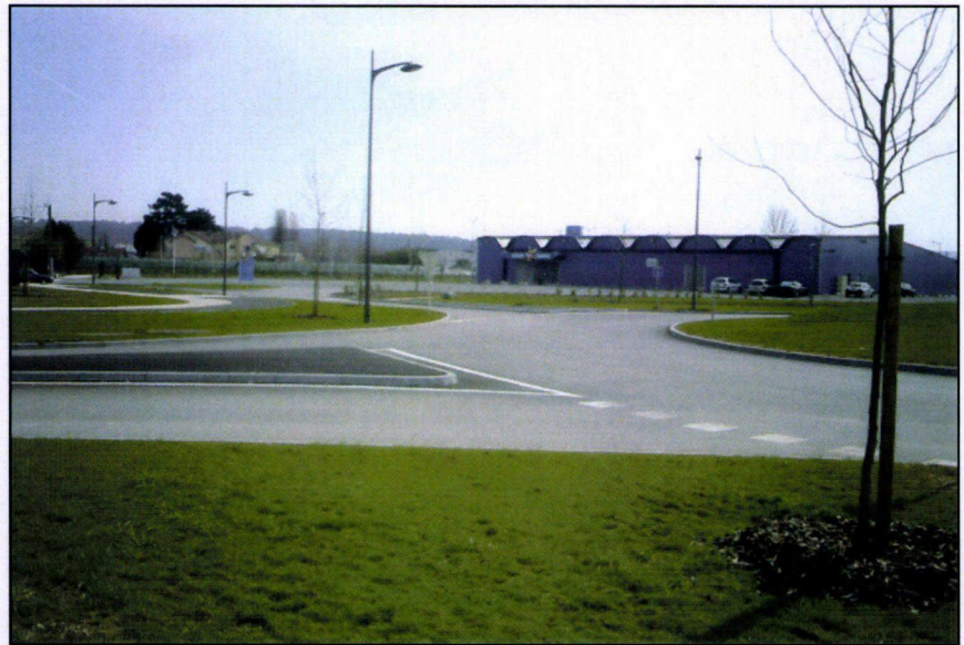
Installation du Bowling et rond point d'accès à l'Espace Lumière
