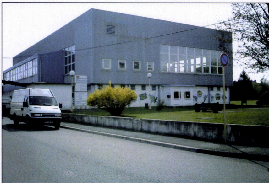
Piscine couverte à Valentigney (travaux en cours)
