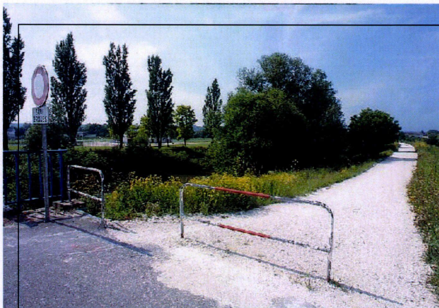
Voie sur berges de la Savoureuse à Vieux-Charmont
