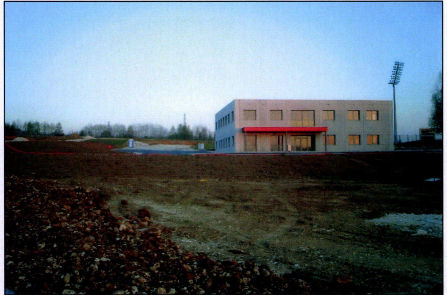
Le First, bâtiment à vocation tertiaire, en cours de construction
