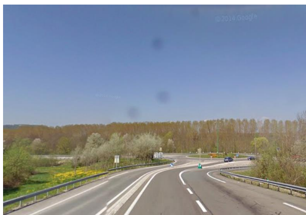
Entrée depuis l'échangeur de Voujeaucourt-Arbouans
