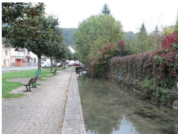
Colombier-Fontaine – Aménagements au centre
