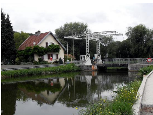
Pont basculant à Courcelles-lès Montbéliard
