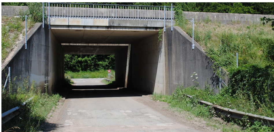
Franchissement routier inférieur de l'A36 avec un environnement perméable à la faune à conserver. (image : Déforêt T.)
