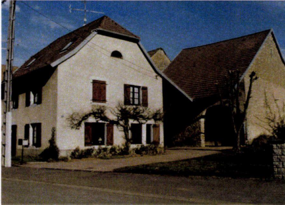
Des bâtiments rénovés jouxent des corps de ferme
