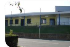
Réhabilitation centre Côteau Jouvent
