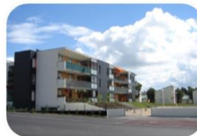
Flandres 30 logements Habitat 25
