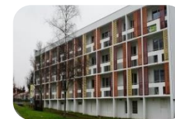
Bâtiment D Néolia
