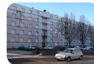
Bâtiment A Néolia
