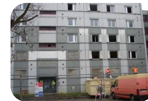
Bâtiment N Néolia
