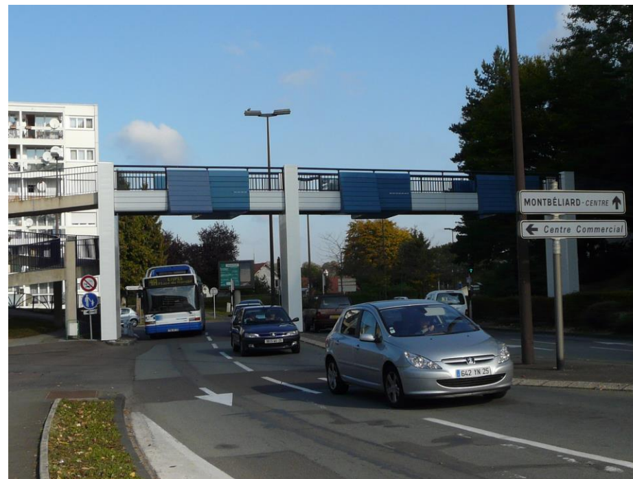
Source : ADU – Passerelle du Côteau Jouvent
