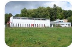
Démolition école Boudard
