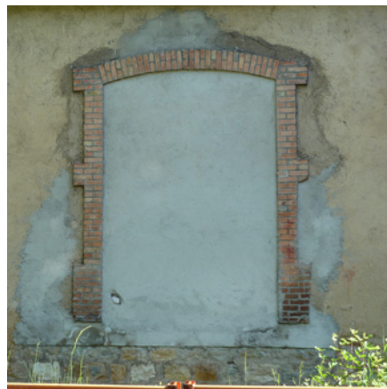
Détail d'encadrement d'une baie obturée.
