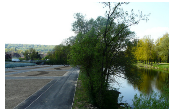
Une passerelle sur le Doubs permet de relier les Andanges et la gare au centre historique de Voujeaucourt.
