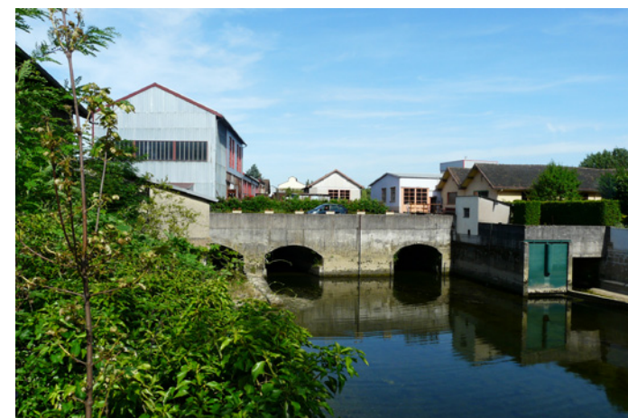
Canal de dérivation du Doubs passant sous l'usine hydroélectrique.
