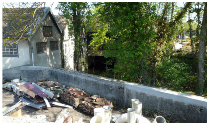
Les anciens ateliers de la fonderie avec ses toits à longs pans.
