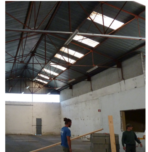
Fesches-le-Châtel : espace potentiellement traversant et lumineux.
