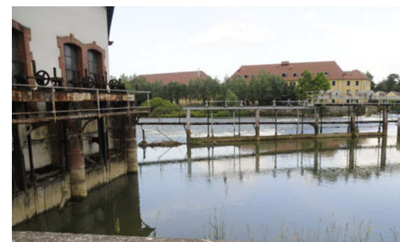
Le barrage sur le Doubs et le pignon sud du site industriel Peugeot-Japy, deux éléments emblématiques. En arrière-plan les filatures réhabilitées par Jean-Pierre Drezet et les espaces paysagers conçus par Alfred Peter. Photographie Claude Nardin © ADU.
