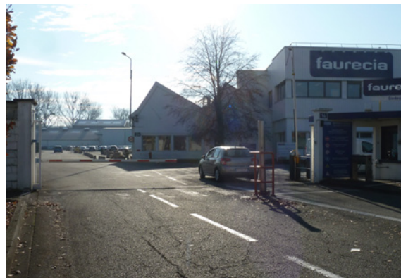
L'entrée du site Faurecia Siedoubs. Les bâtiments ont été rhabillés de bardage métallique. On lit encore les toitures à sheds.
