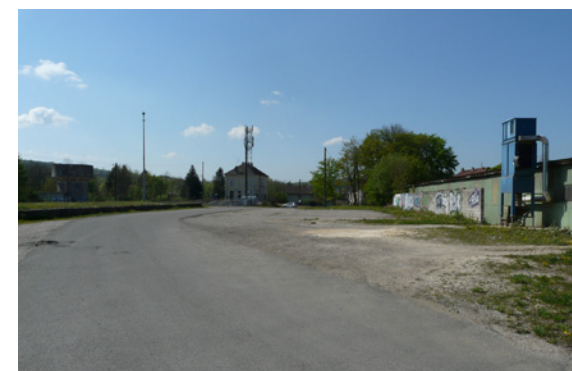
Les abords de la gare et l'arrière du site renvoient une image de délaissés.
