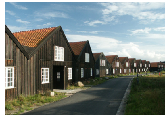
Copenhague : locaux tertiaires aménagés dans d'anciens hangars en bois.
