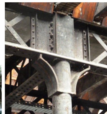
Établissement Noiroit (détail de la structure).
