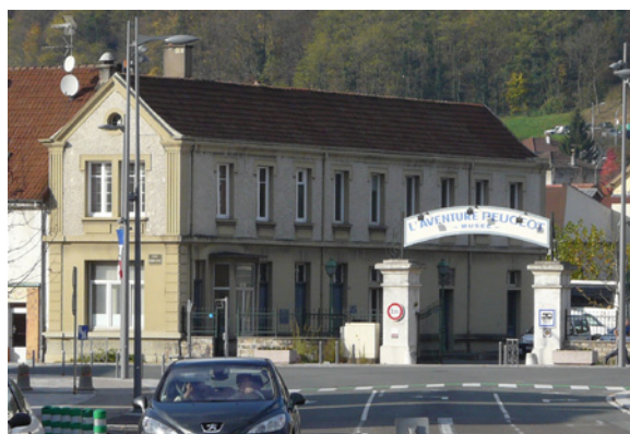
Ancienne conciergerie. Les façades de ce bâtiment ont été remaniées.
