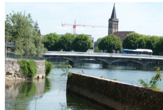
Un site à deux pas du centre-ville d'Audincourt et du pôle d'échange « Temple ». En arrière-plan les travaux sur l'espace Bazaine qui comptera plus de 100 logements à terme.
