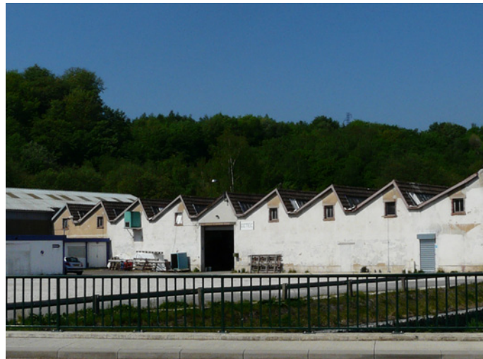
Le bâtiment à sheds situé au Nord du Rondelot a subi de nombreuses modifications des ouvertures.
