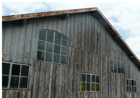
Façade en bois d'un hangar légèrement surélevé par rapport au terrain.
