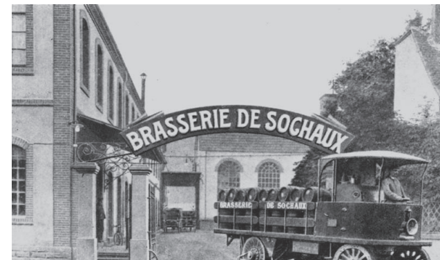
A l'origine, les angles et les encadrements en brique de l'ancienne conciergerie étaient apparents.
