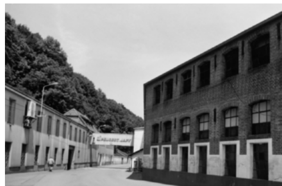
L'ancien atelier de contrôle aujourd'hui démolit. Source : Inventaire général du patrimoine de Franche-Comté. Photographie Jérôme Mongreville.
