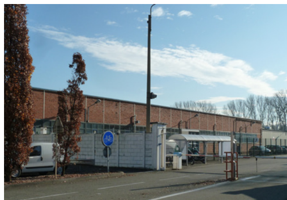
La partie latérale du bâtiment occupée par les « occasions du Lion » laisse apparaître le remplissage en brique des façades (bâtiment postérieur à 1940).
