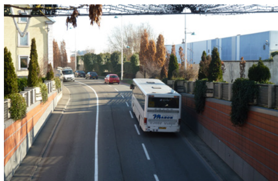
Le long de l'avenue d'Helvétie, le site est masqué par un mur d'enceinte en béton qui se prolonge par un mur ancien en moellons de pierres calcaires enduites à la chaux.
