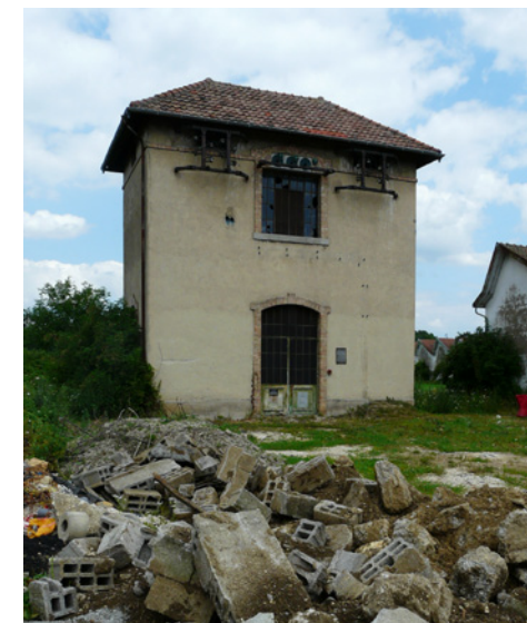
Ancien poste de transformation électrique l'un des éléments verticaux avec la chaufferie et la salle des machines.
