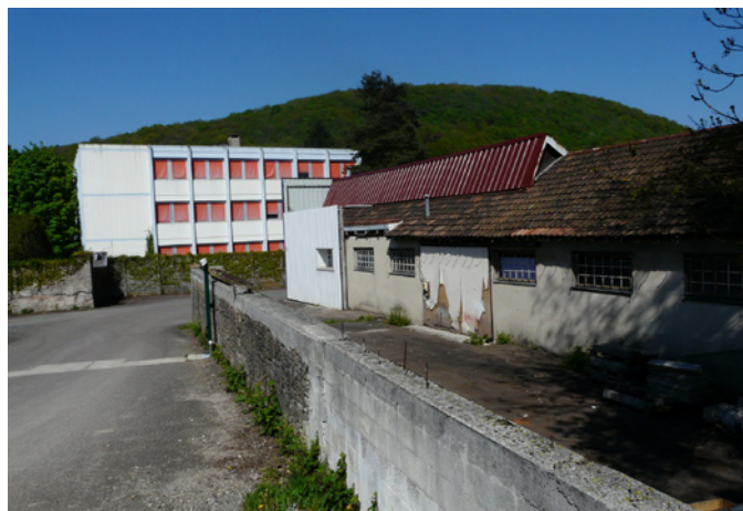
Les bâtiments anciens ont été habillés de bardage métallique. A l'arrière-plan, le bâtiment de bureaux des années 1970, inoccupé à ce jour.
