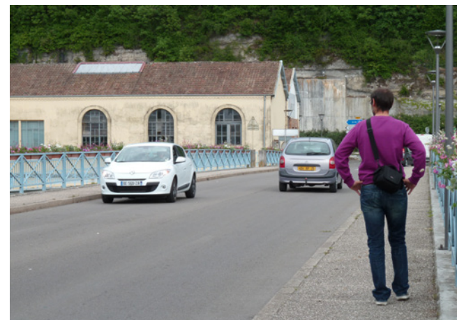
Vue du site industriel depuis le pont de la Libération.
