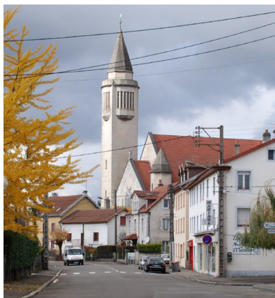
Réseaux aériens et traitement minimal des espaces publics à proximité du monument historique de l'Immaculée Conception.
