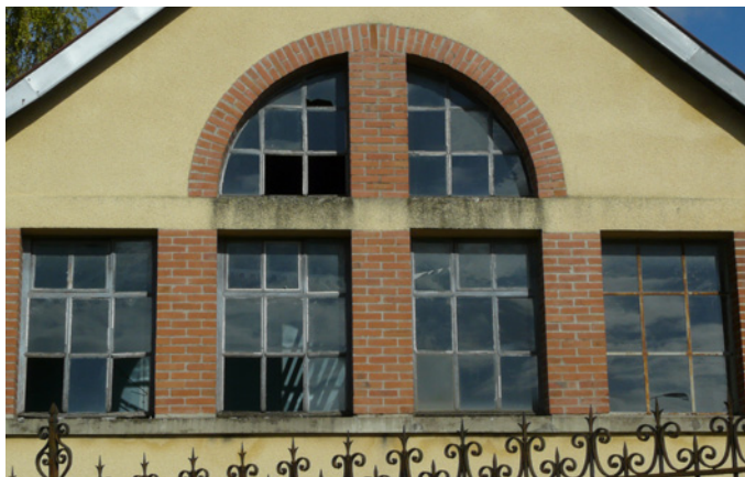
Pignon de l'un des bâtiments anciens, l'un des derniers témoins du site de production.
