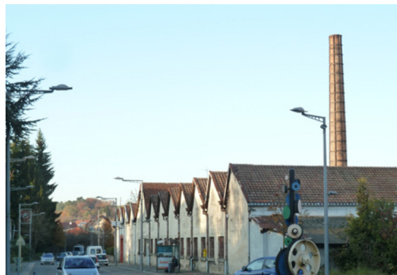
Vue de l'usine depuis la RD 34 en provenance d'Hérimoncourt.
