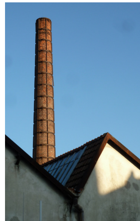
La dernière cheminée de la vallée du Gland.
