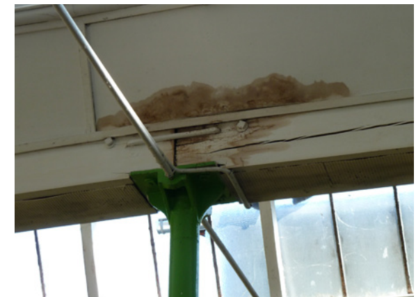
Détail de connexion poutres bois / poteau fonte.
