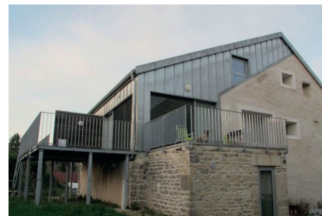
Réhabilitation d'une ferme en logements et atelier communal, Charnay (25), Observatoire CAUE © KLEIN Architectes, CAUE du Doubs
